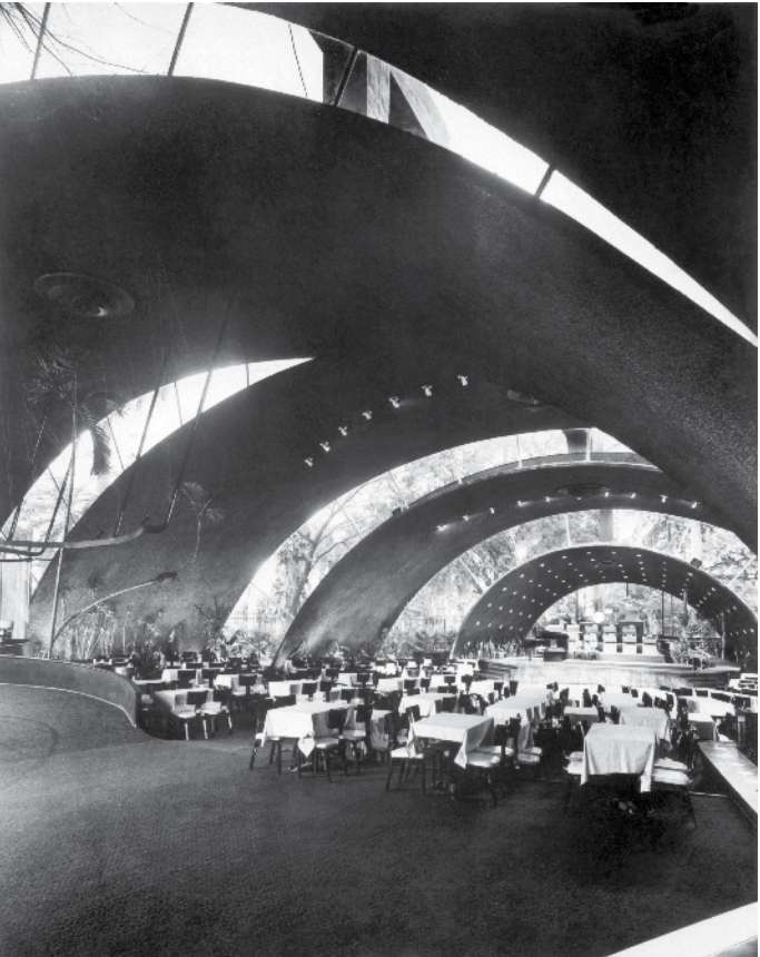
Cabaret Tropicana. Arquitectos: Max Borges Recio y Héctor Carrillo. Arcos de cristal, 1951. Sala Bajo las estrellas, 1952. Casino, 1954. Casino Popular y galería externa, 1956.
